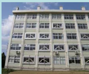
【校舎の耐震補強】
