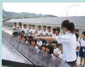
【太陽光パネルの設置】
