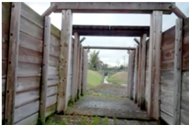
▲本来は立ち入れない用水路の中から(自撮り棒+カメラ)
