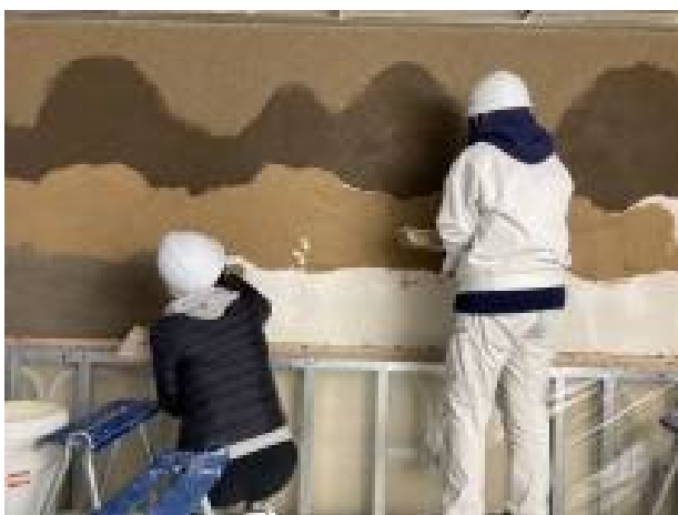
教職員等が参加したトイレの土壁施工の様子
